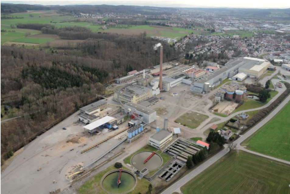
Abb. 2.8: Die Papierfabrik STORA-ENSO in Baienfurt 2010 nach Schließung des Werks (Foto: Rey)
