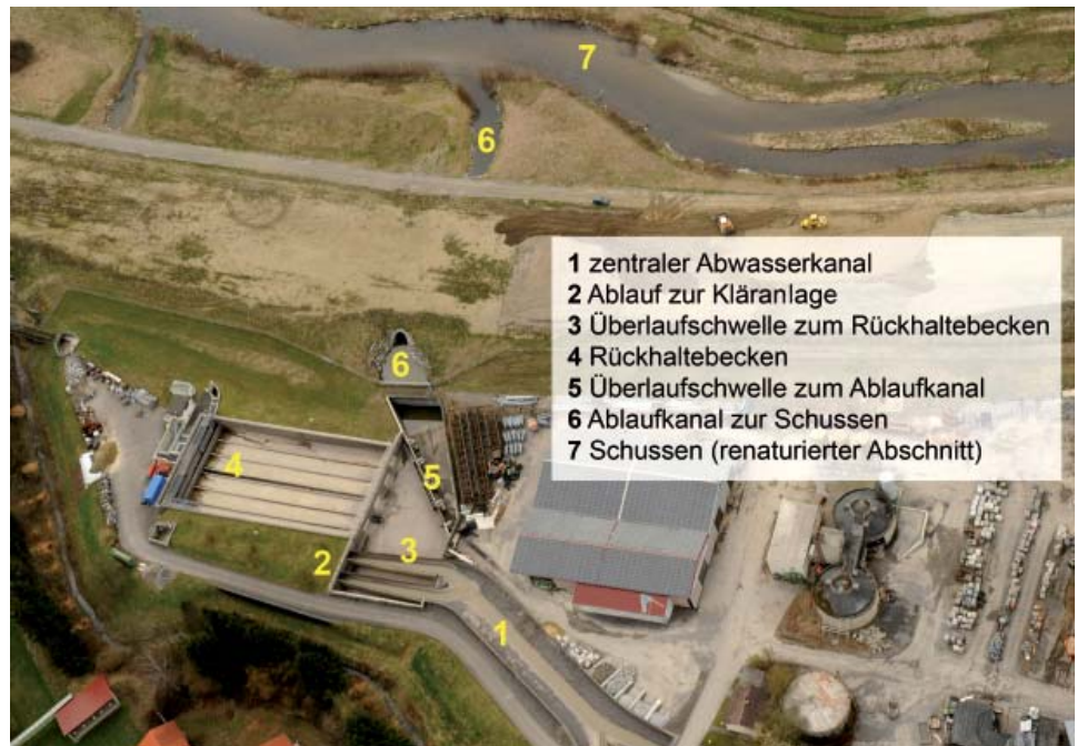
Abb. 3.2: Regenentlastung am Beispiel der Anlage Mariatal (Foto: Rey)
